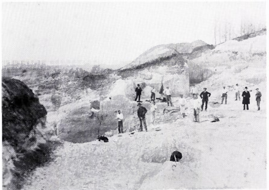
Figuur 13. Dagbouwwinning van losse mergel rond 1914 in de "groeve Duchateau" naast de voormalige Franse Batterij (voor de huidige situatie zie fig. 15). Op de achtergrond de westelijke Jekerdalhelling (Cannerberg / Louwberg; foto: collectie M. Wijnen).
